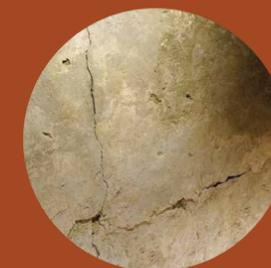
**7 Fratura no reboco** | Linha de fratura no reboco, que se estende diagonalmente entre o topo da sapata e a parte superior da muralha. Terá resultado de um sismo, provavelmente o terramoto de 1755.
