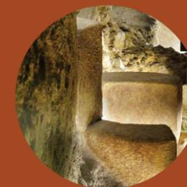
**8 Poço pombalino** | O poço pombalino foi construído depois de 1755, quando a muralha já estava soterrada e a circulação se fazia a um nível do solo próximo do atual. Os poços permitiam o fornecimento de água (por vezes potável) para as tarefas domésticas e, sobretudo, garantiam as reservas necessárias para combater os incêndios na cidade.
